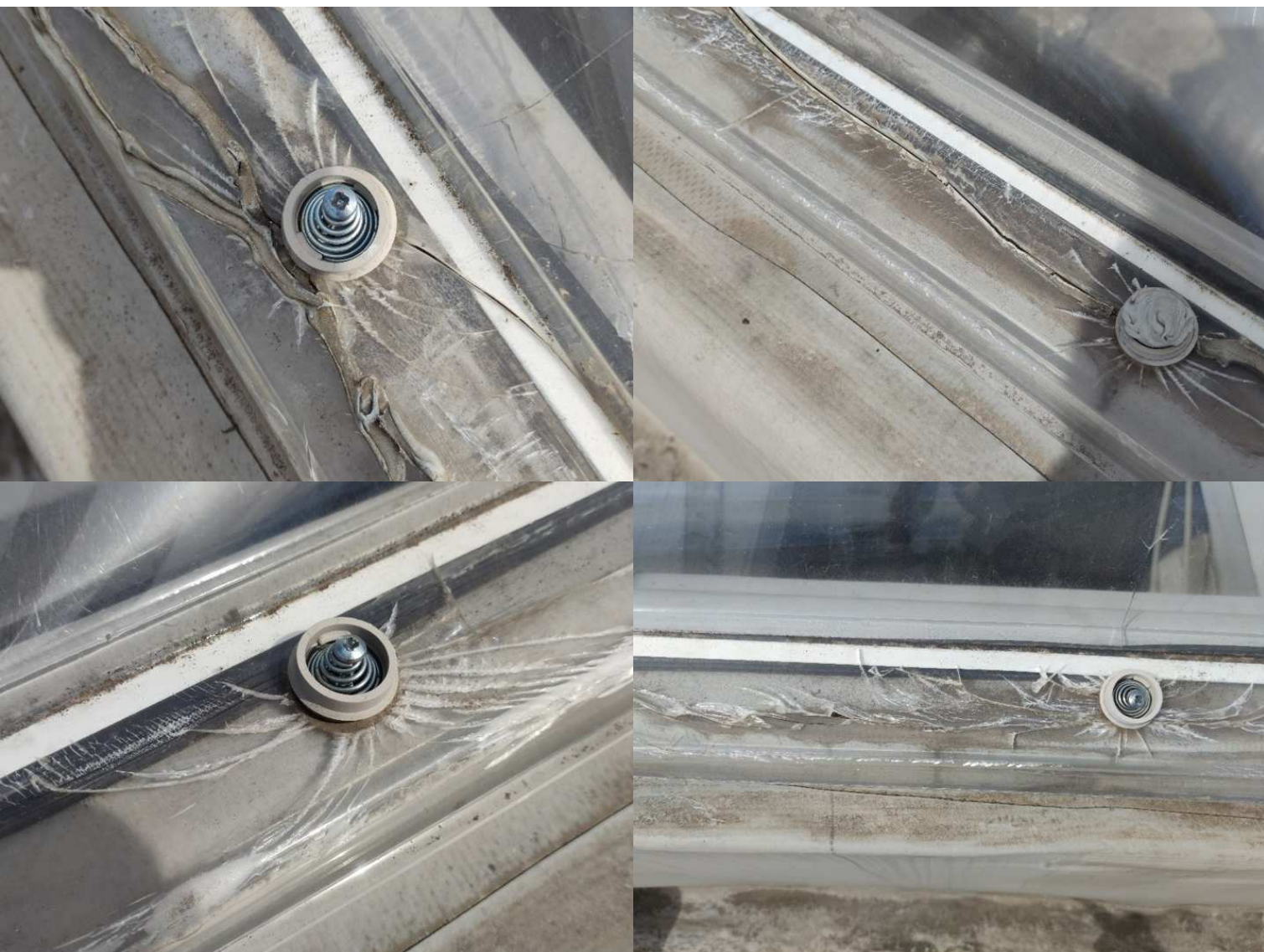
Дефекты герметизации парапетных крышек
