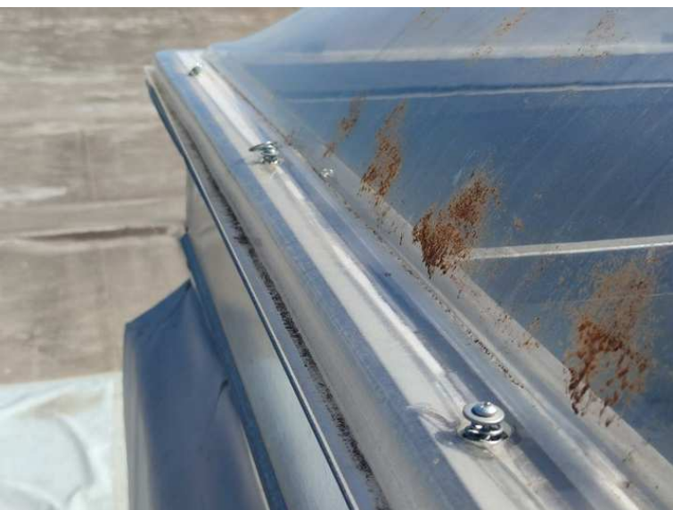
Нарушение герметизации зенитных фонарей
