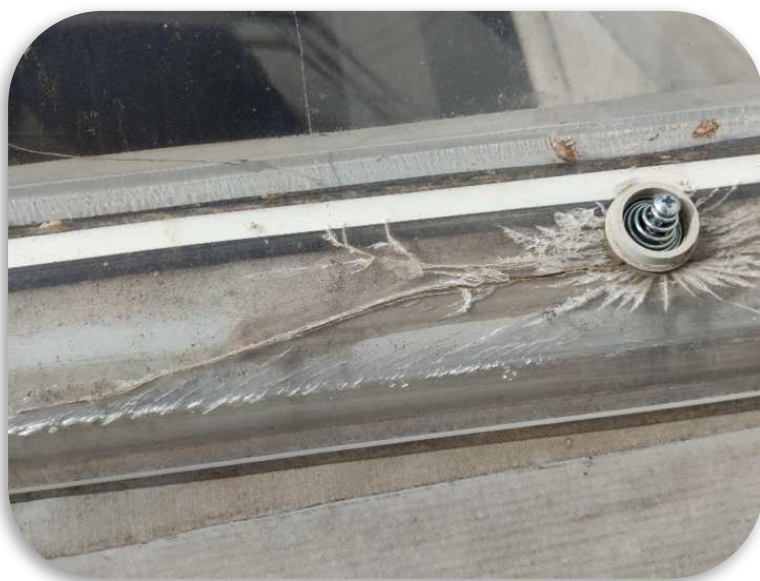
Дефекты герметизации парапетных крышек
