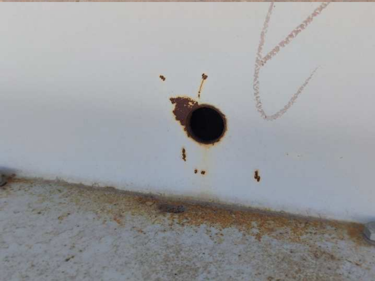
Нарушение герметизации зенитных фонарей
