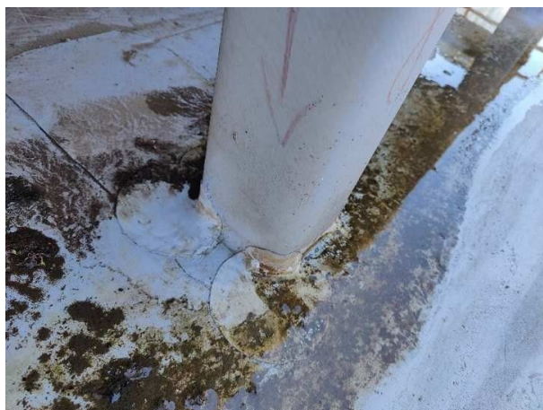
Фото 19. После ремонта (Г1): заплаты у основания стойки
