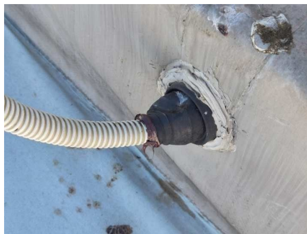
Фото 20. После ремонта (Г2): повторная герметизация проходного элемента
