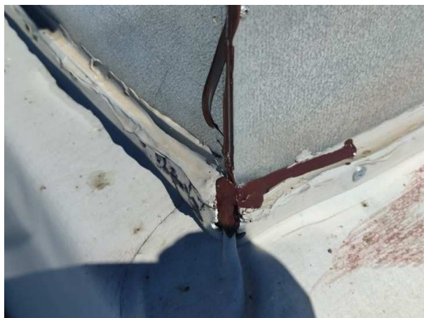
Фото 21. После ремонта (ГЗ): герметизация угла примыкания с краевой рейкой
