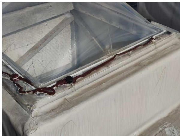
Фото 22. После ремонта (Г5): герметизация периметра и точек крепления зенитного фонаря
