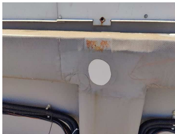
Фото 18. После ремонта (Г1): заплата на вертикальном участке примыкания
