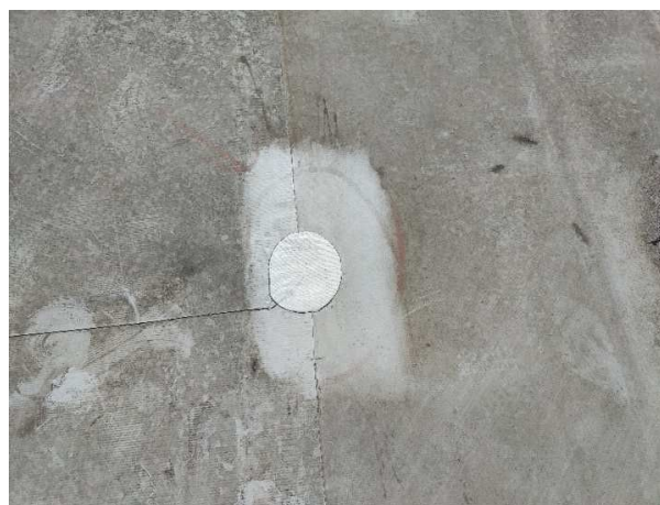
Фото 16. После ремонта (Г1): заплата из ПВХ-мембраны на повреждении у сварного шва
