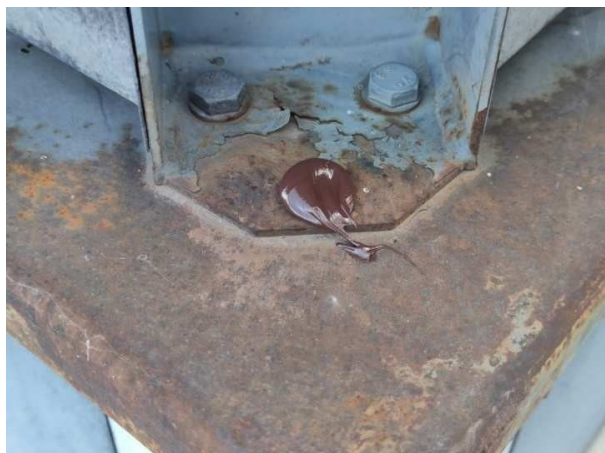
Фото 23. После ремонта (Г4): герметизация отверстия в опоре оборудования
