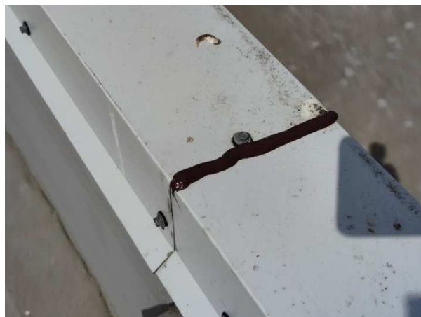
Фото 24. После ремонта (Г6): герметизация стыка парапетных крышек
