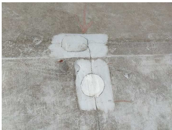
Фото 17. После ремонта (Г1): заплаты на повреждениях по линии швов
