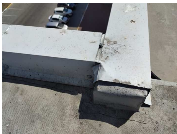
Фото 12. Г6. Парапетная крышка: негерметичный стык элементов
