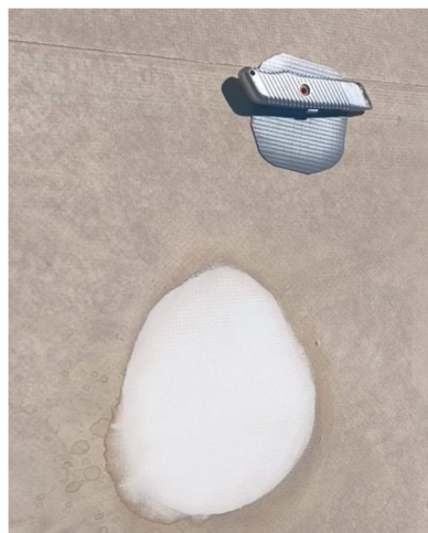
Фото 8. Участок пробной сварки ремонтной латки (Дефект № 4)
