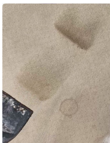
Фото 10. После нагрева мембрана не плавится, а темнеет и подгорает (Дефект № 4)
