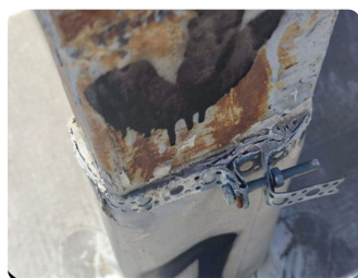
5. Опора: хомут и герметик
